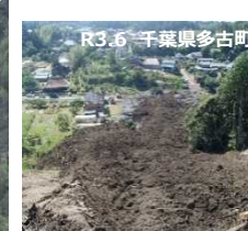
R3.6 千葉県多古町 廃棄された土石の崩落 軽傷者1名、県道通行止め
