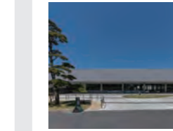
福岡病院中央棟 笹栗久幸・平山雅司・西朋子・ 西村章・松竹勲臣・井上雄二・ 藤田勝道 (株)竹中工務店
