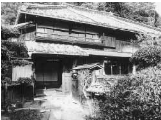
工事前の全景
