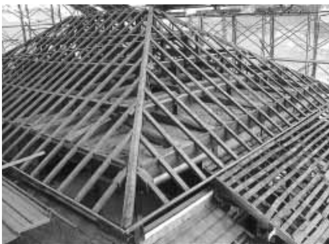
仮設屋根に囲まれた小屋組
