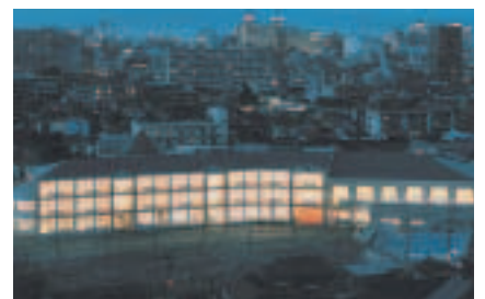
外観(南面夜景)
