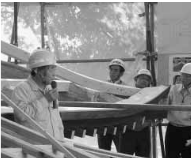
—現場説明会風景—
