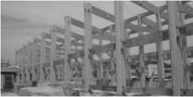
写真10 大展示室（屋根架構前）
