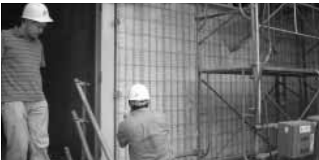
写真13 生分解性プラスチックを用いた外壁
