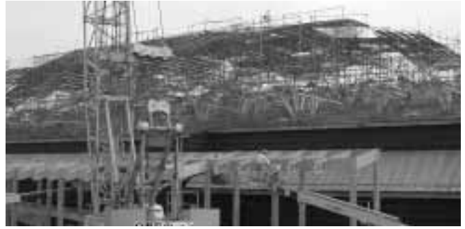
写真14 外観（竹ケージの施工中）
