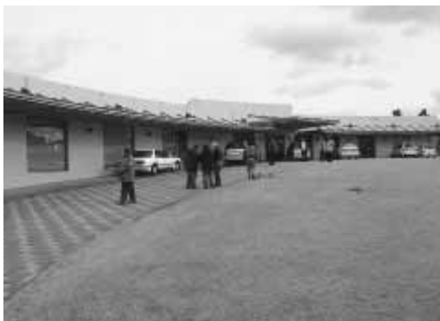
(西館入口付近)
