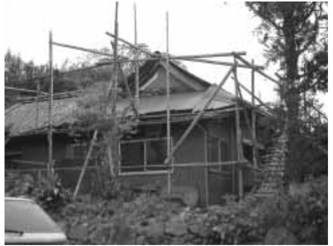
襟江亭（瓦を降ろしている）
