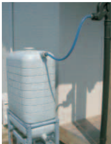
雨水を堅樋いから引き込むエコレイン
