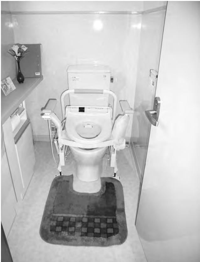
【改修後】 ななめ昇降式便座とドアノブをレバーハンドルに交換
