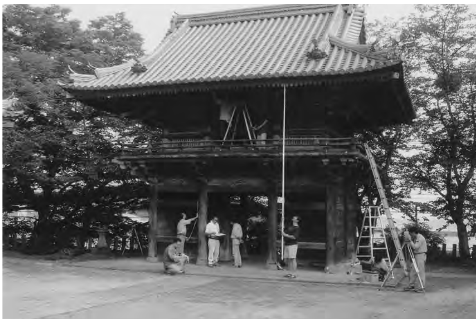
現地調査の様子
