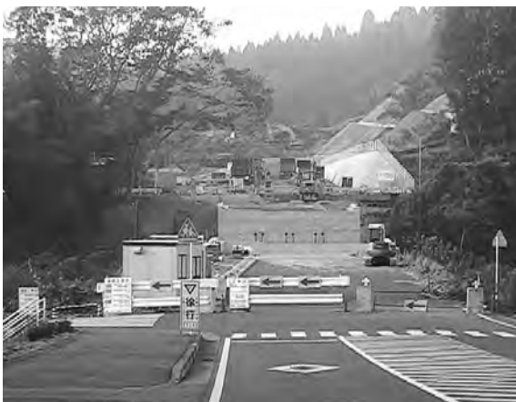
工事中のバイパス旧役場付近
