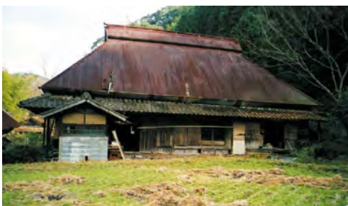
『改修前の古民家』
