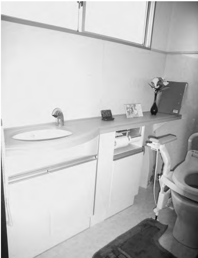
【改修後】 「手すり」として使えるカウンタートップ
