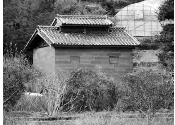
新しく見つかった千怒地区にある貯蔵庫
