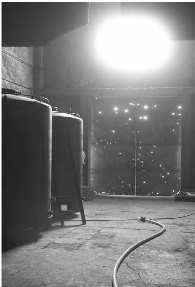
実際に機銃を受けた道路側の扉
