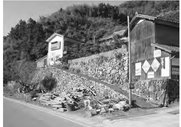
水害対策の為高く築かれた石積み擁壁と家屋
