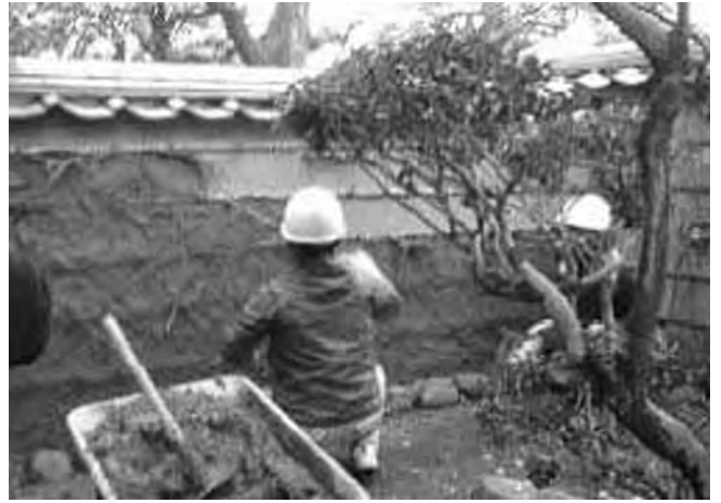
福澤諭吉旧居の土塀修復作業
