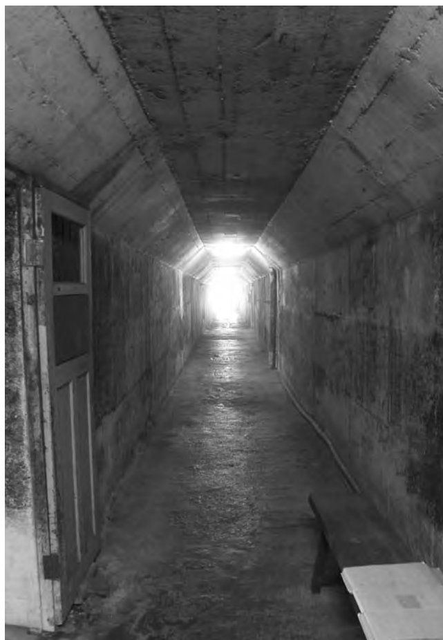
テスト区画を貫く通路
