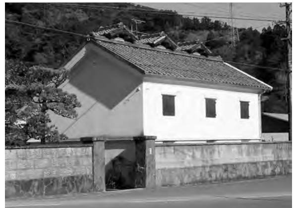
ミカン貯蔵庫の換気棟の向きに注目：風の流れ
