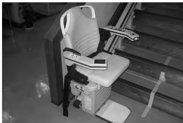
対応例2:「階段昇降機の設置」
