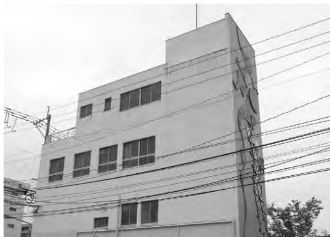
上部を継ぎ足した様子がわかる
