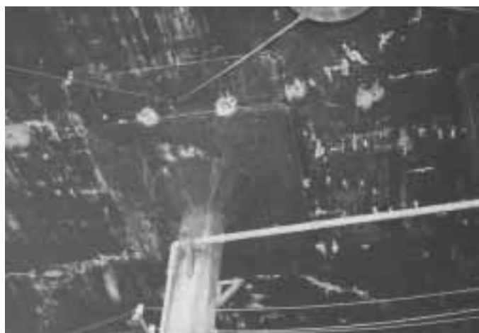
床板を直接柱で支える無梁版構造
