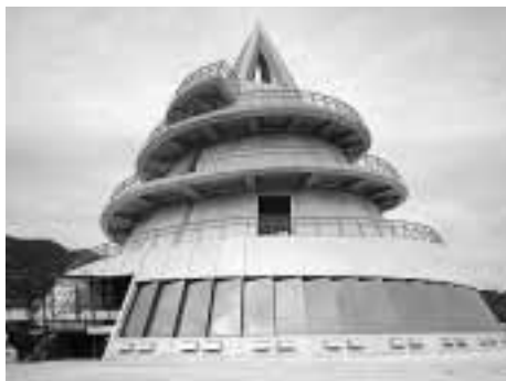
フェリーターミナル外観
