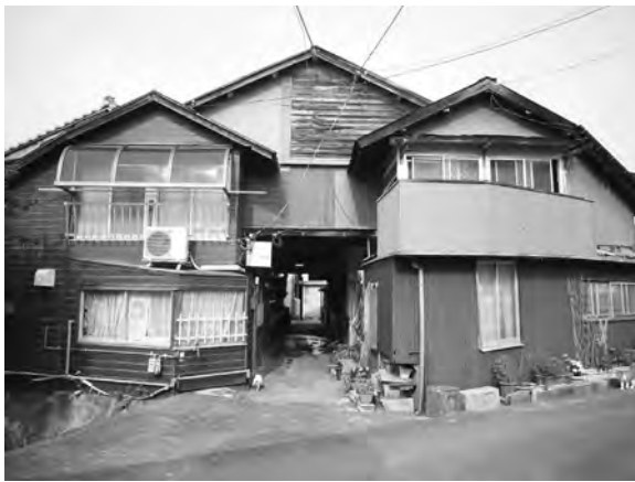
建物 南側外観
