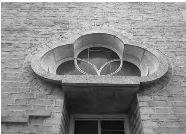
外壁部分。レンガの目地はわざと粗く仕上げられており、ディテールの随所から“人の手”が感じられました。
