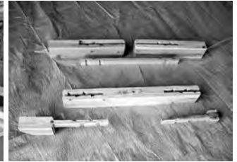
仕口・継手製作 作業風景
