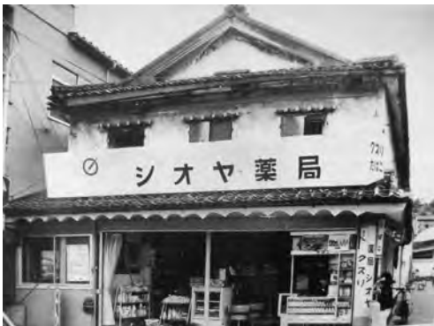
保存修理前の状況
