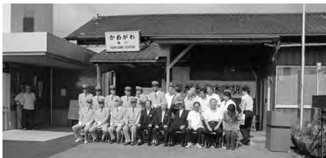
【左側の待合室は解体されファサードは残っていない。】
