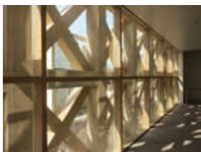
壁面の木造トラス
