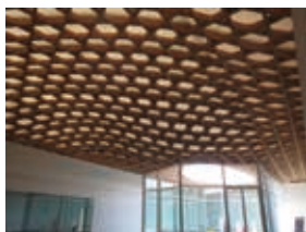
木構造を用いた天井
