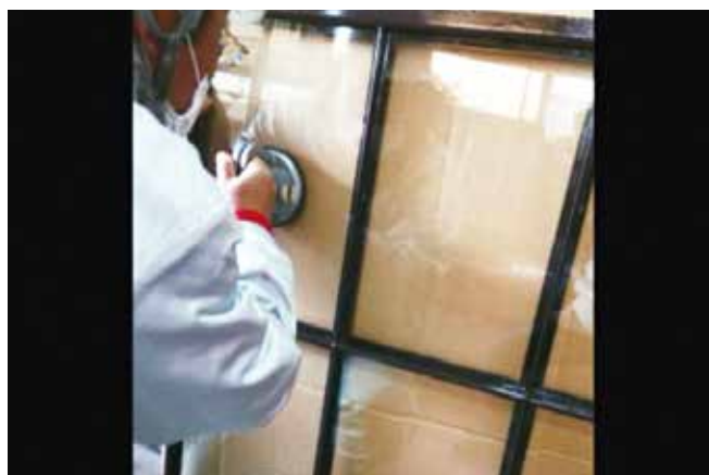
【ガラス取付完了】
