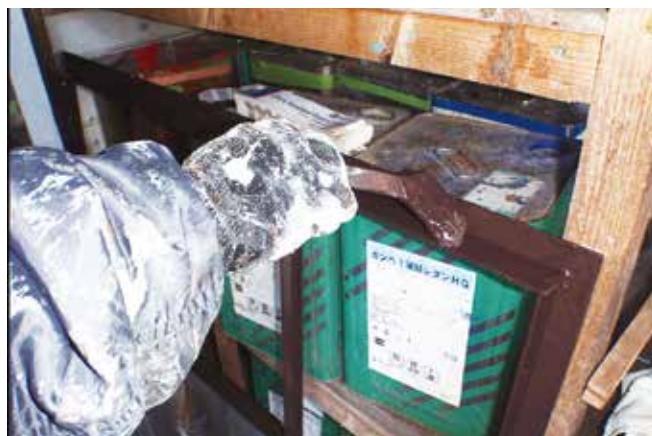
【上塗り色は現況に近い錆色】
