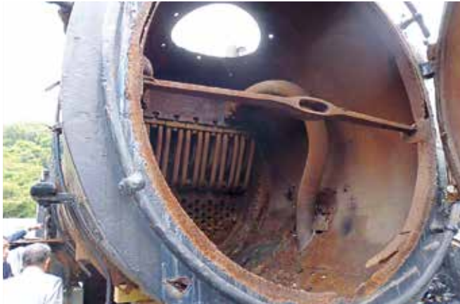
【修理前のボイラー部分】
