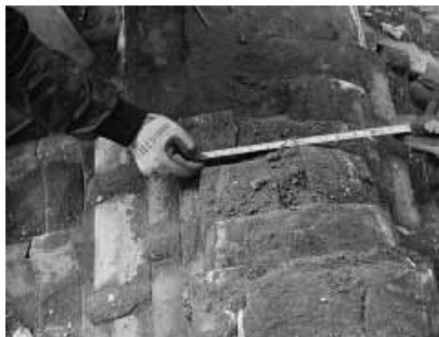
解体、調査中の酒造蔵
