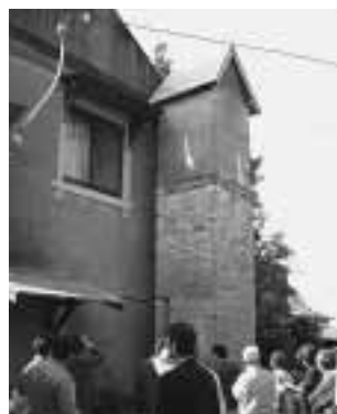
住宅給水塔 住宅東蔵
