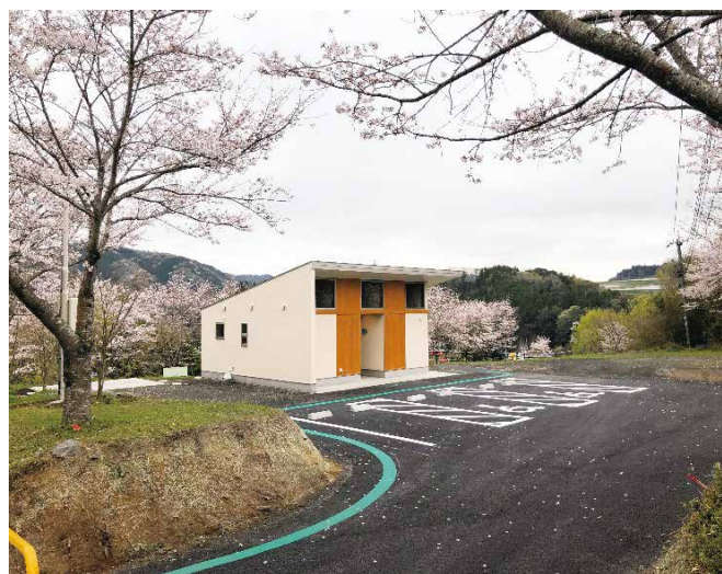
道路側からの外観
