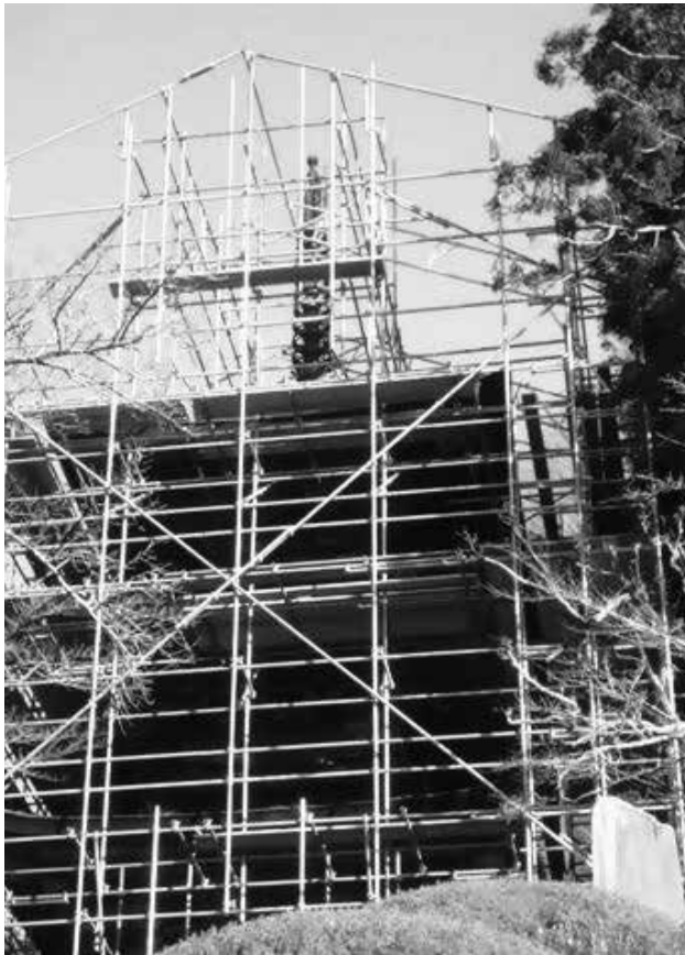
(写真3)大法寺三重塔
