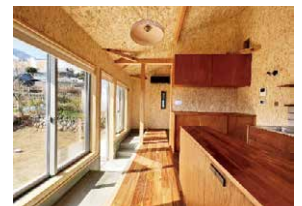
冬季の日射を南向きの土間に蓄える。(写真は1月頃)
