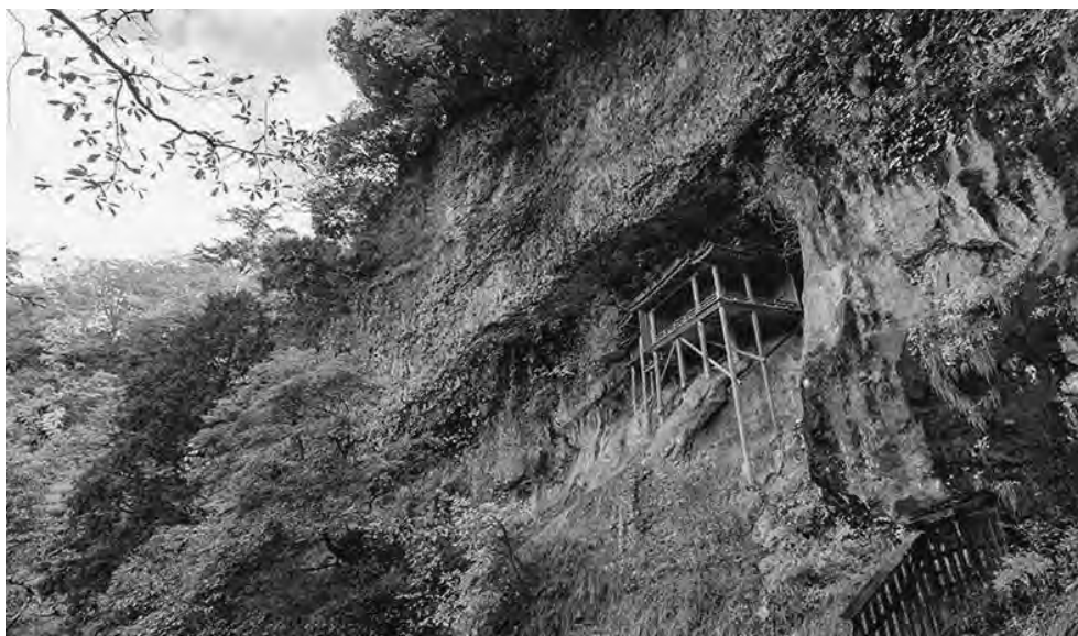
写真1 遠景の投入堂
