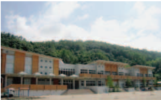
小学校校舎を見る
