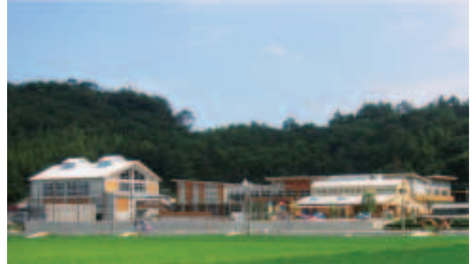
外観全景～左から体育館・小学校・幼稚園園舎
