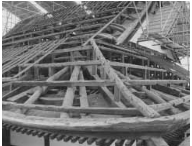
野地解体後：野垂木一部解体
