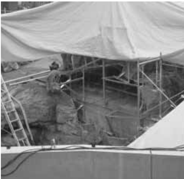
施工中の擬岩工事
