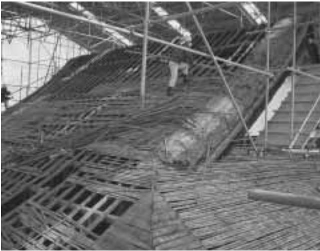
野地解体：葺き土の下地は大半が竹木舞で、一部近年の修理部分が板であった。
