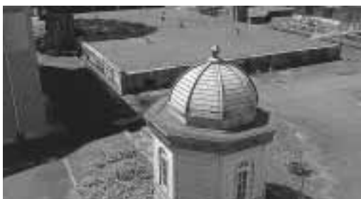
集合井室と配水池
