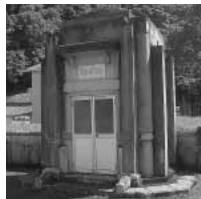
配水池出入口
