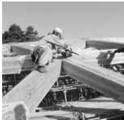
部材の接合(鋼板のボルト接合)
