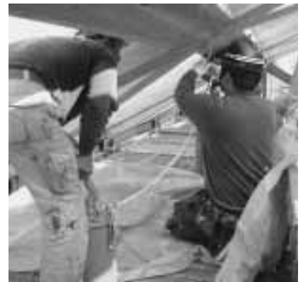
接合部(エポキシ樹脂注入)
