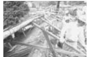
瓦を一枚ずつ剥ぎ取り丁寧に下へと降ろしていく
