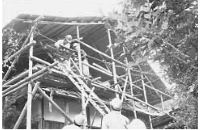
瓦を一枚ずつ剥ぎ取り丁寧に下へと降ろしていく
