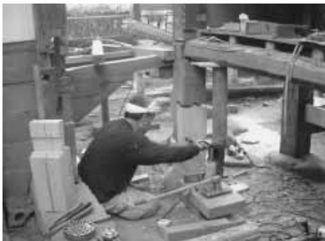
当初材保存のための柱根継の施工（長福寺本堂）
