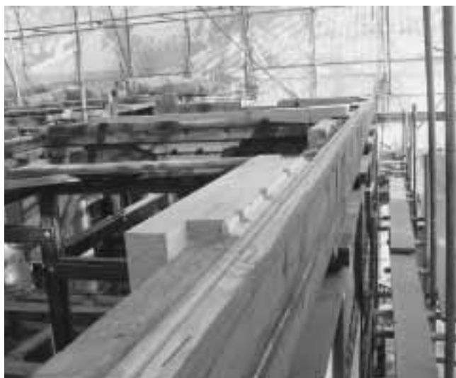
丸桁を修理し、梁掛かり部分を木材にて補強。補強材は継ぎ手工法と契りによって継いでいる。（長福寺本堂）
