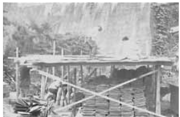
仮小屋を設置して瓦を隣地に保管する
