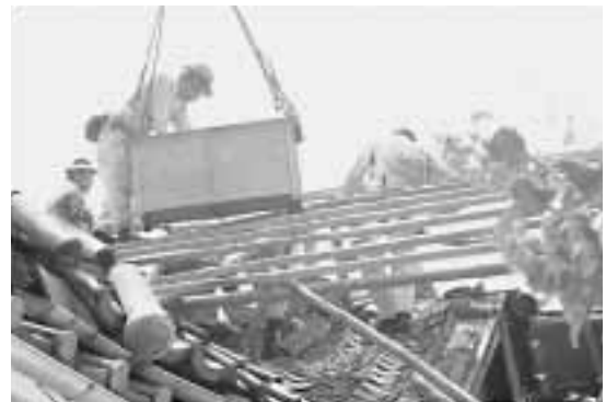
瓦の次に下地の葺き土をコンテナに載せて降ろしていく
