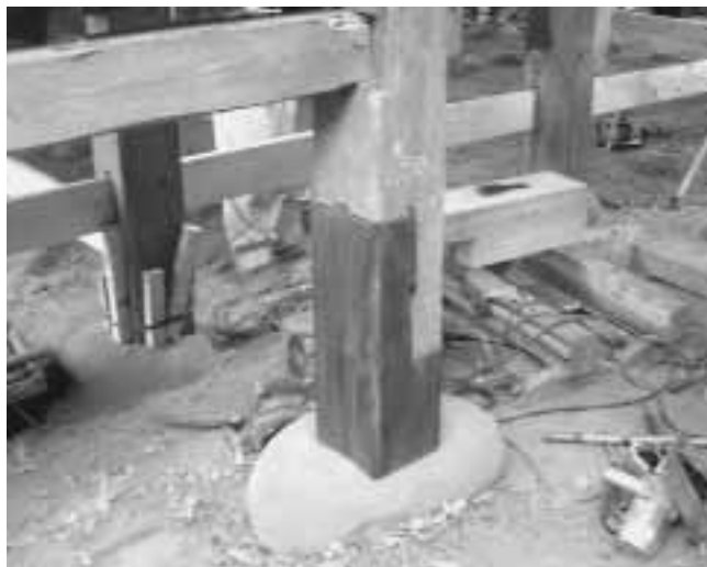
柱根継完了：古色仕上げ（長福寺本堂）
