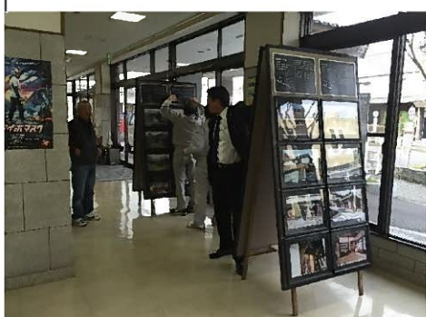
設置作業(杵築市役所)
