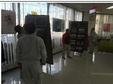
設置作業(大分銀行杵築支店)
