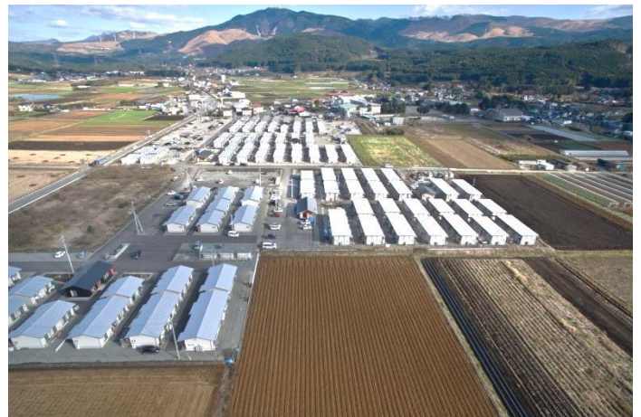
熊本地震で整備した熊本型の応急仮設住宅（西原村小森仮設団地）写真：kulos
