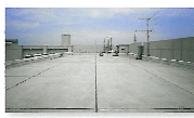
アスファルト防水弾丸コンクリート仕上げ 仕様耐用年数 約17年(20~32年)
